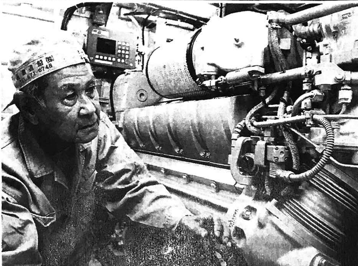
エンジン整備を始めて半世紀以上。優れた技術力で信頼が厚い西田誓志さん(神戸市兵庫区七宮町)
